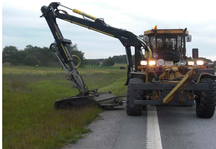
Bild 2 Slättning maskinellt med slätteraggregat.
