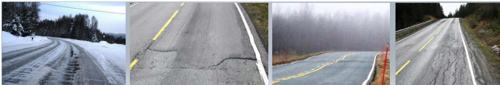
Bild 9 visar eventuella skador som uppstår när tjäle finns i marken och ingen av ovan nämnda lösningar utförts (Foto: Johan Granlund).
